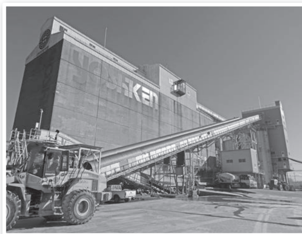
骨材ストックヤードとベルトコンベヤ
